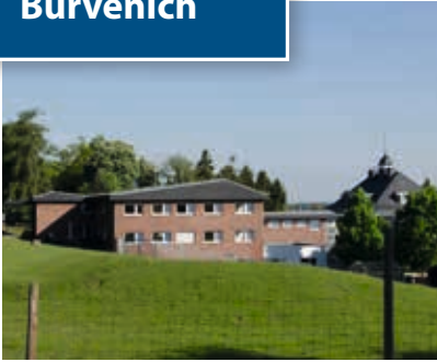
Erwachsenenwohnen Wohnstätte im Förderzentrum
